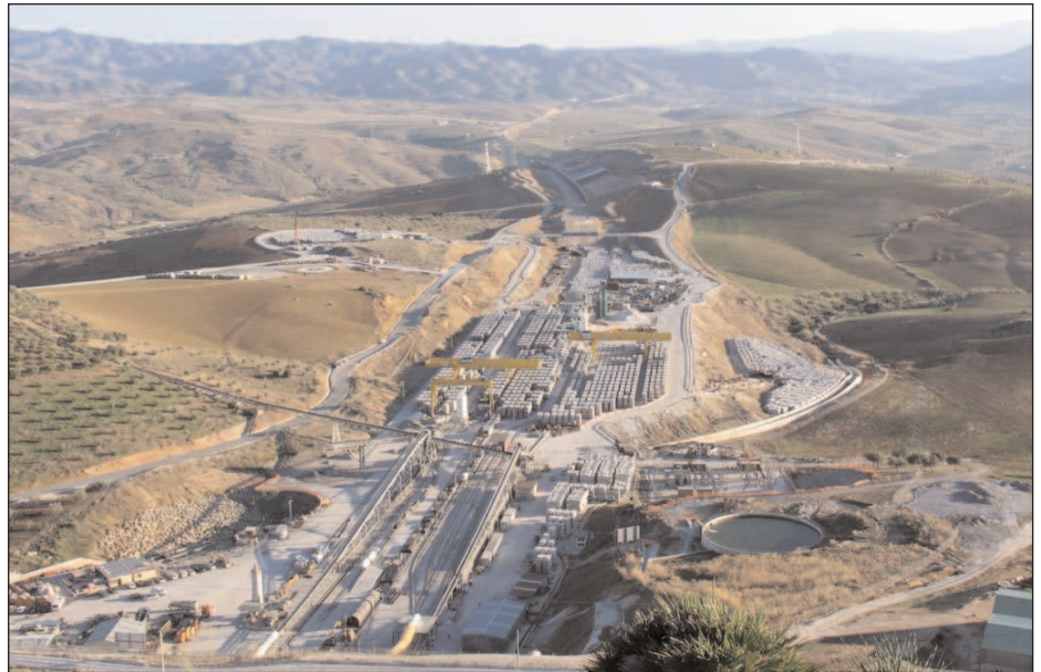
Obras nuevo trazado del AVE Madrid-Málaga
